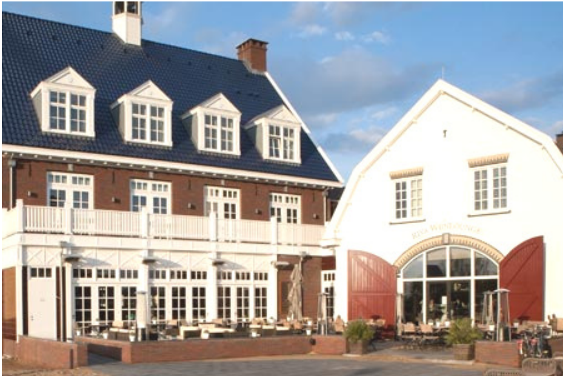
Voorbeeld Nautisch Kwartier Huizen – geslaagde nieuwbouw in oude stijl
